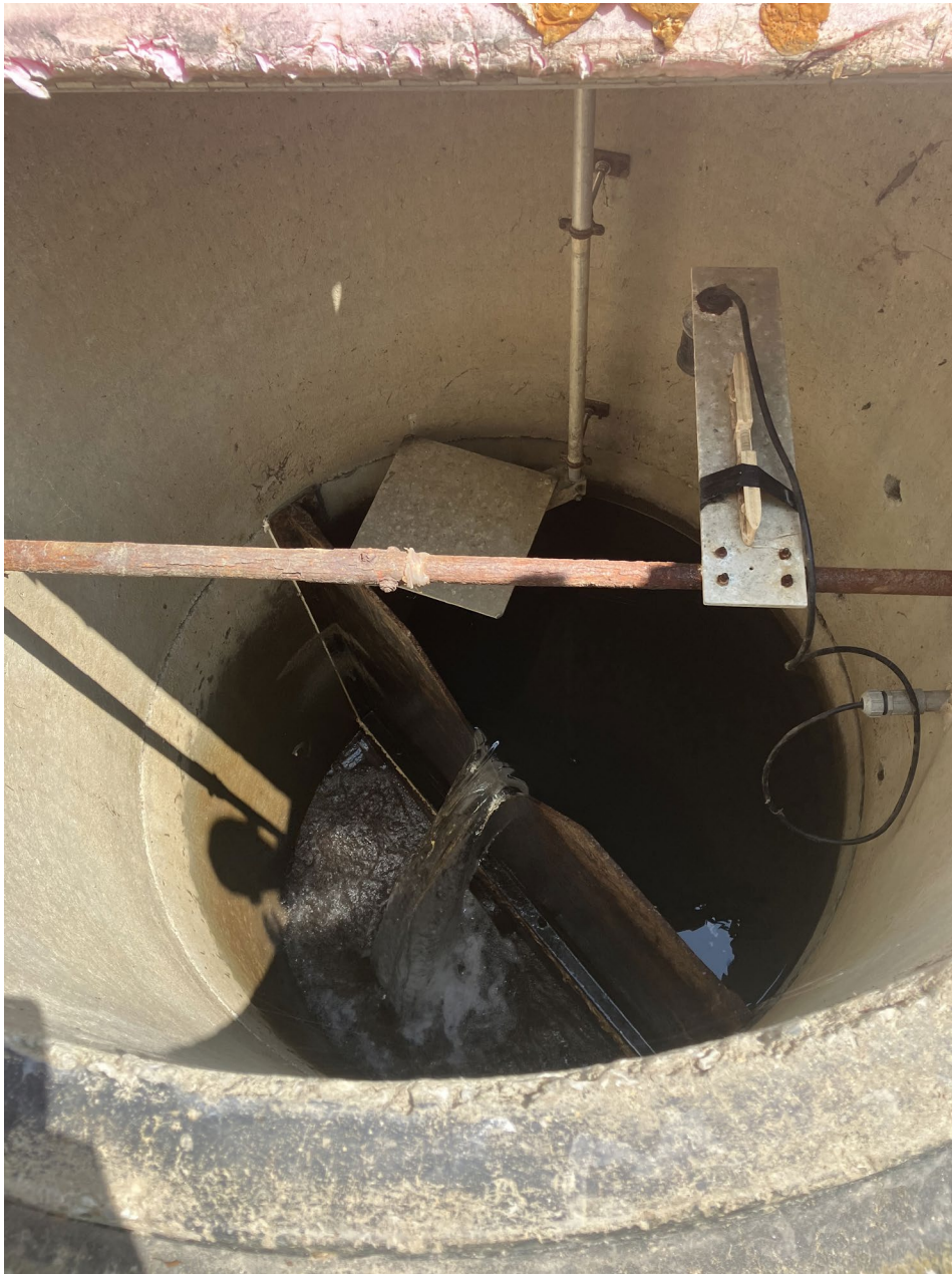
7- Effluent Weir
